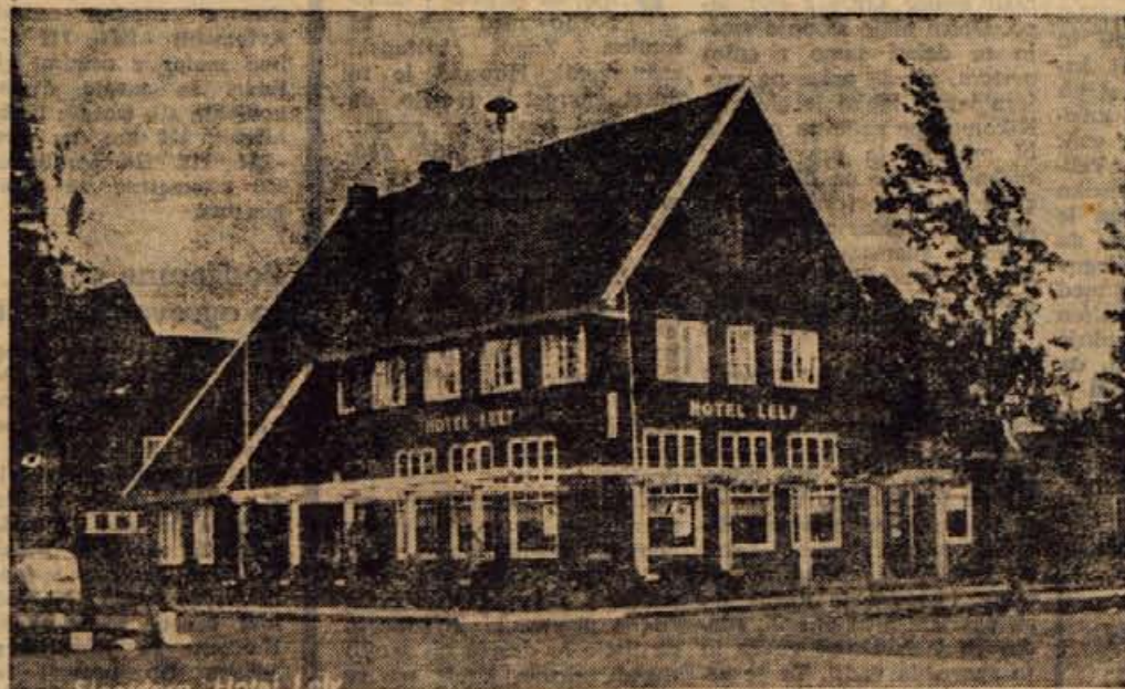
Leta 1945., ko so se Nemci umikali z Nizozemskega, so porušili zapornice in voda je prekrila kopno, ki so ga Nizozemci z velikim trudom izsušili. Hiša, ki jo vidite na sliki je v vasi, ki je bila cela pod vodo. Voda je v tem vaškem hotelu stala do zgornjih oken v prvem nadstropju. Vse rastlinstvo je slana morska voda uničila. Drevesa, ki so na sliki, so zrasla potem, ko so vodo zopet izčrpali
