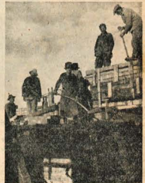
Zidajo se nove zgradbe...
