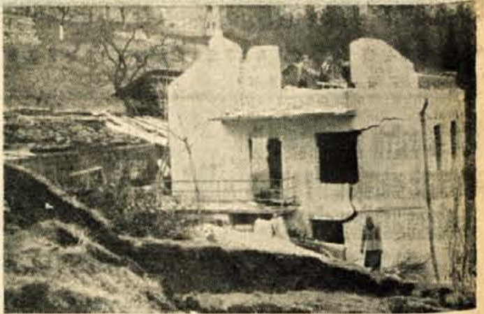
Druga hiša (št. 16) — žrtev zemeljskega plazu v Trziču
