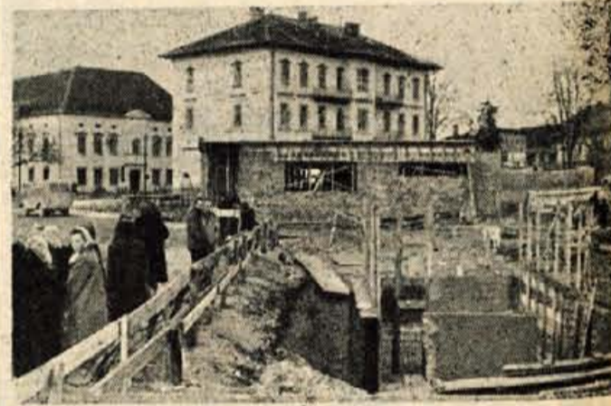
RADOVLJICA DOBIVA NOVO LICE. V središču Radovljice se pred kratkim začeli z gradnjo dveh pomembnih objektov. V ospredju desno bo nova avtobusna postaja, katero številni potniki pogrešajo že vrsto let. V ozadju pa vidite začetek gradnje novega poštnega poslopja.
