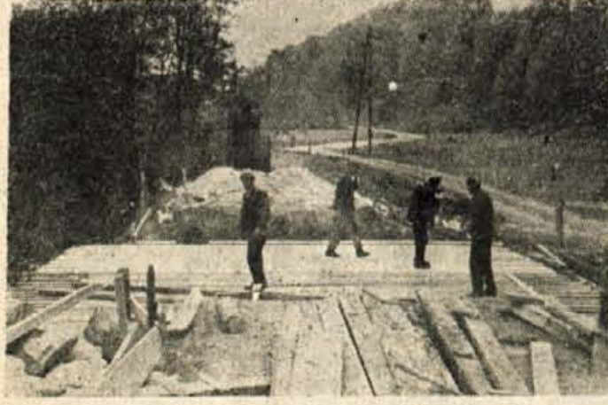
Cesta Radovljica—Kropa bo kmalu spet prehodna za vsa vozila. V Hotunjah so se pred kratkim lotili gradnje betonskega mostu z vs o resnostjo
