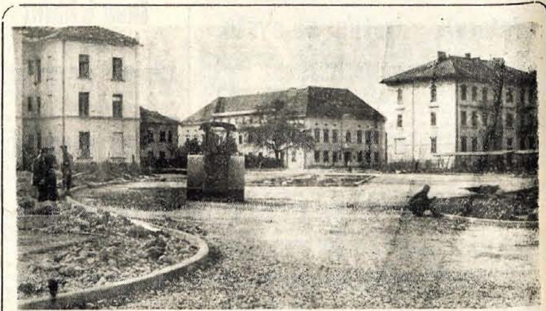
Radovljica nenehno spreminja svojo podobo, vendar s tolikšno naglico, kot zadnji mesec, še dolgo ne. Komaj so zgradili streho na veliki stanovanjski hiši nasproti telovadnega doma, so že pričeli z gradnjo kanalizacije. Zadnje dni pa je predvsem v središču mesta postalo živahno kot na travljšču. Tu že nekaj dni brni motor buldožerja, ki odstranjuje prst in pripravlja zemljišče, na katerem bosta stala novo poštno poslopje in nova avtobusna postaja. Na novo nasutem cestnišču pa se že prevaža valjar, in kmalu se bodo domačini in gostje po novem odcepu od glavne ceste lahko pripeljali v mesto.
