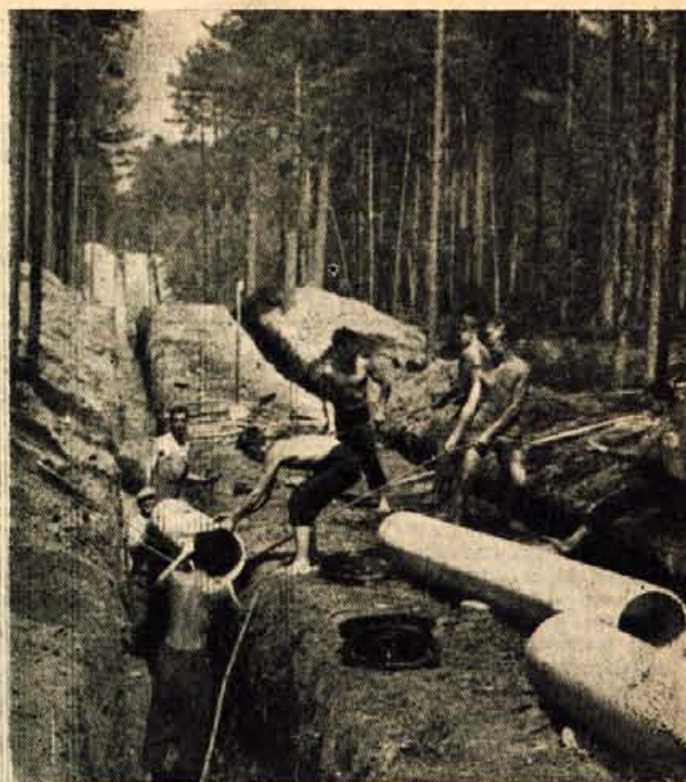
BRIGADIRJI NA SUHI POLAGAJO CEVI ZA VODOVODNO OMRZJE
