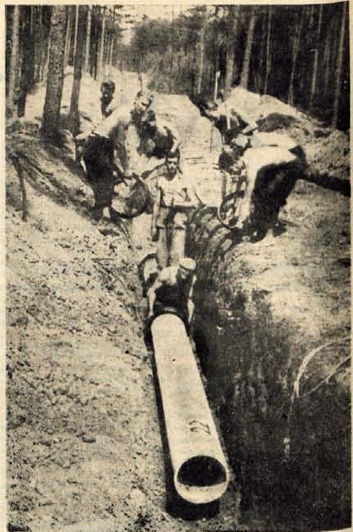
Brigadirji so dosedaj položili že 2700 m vodovodnih cevi
