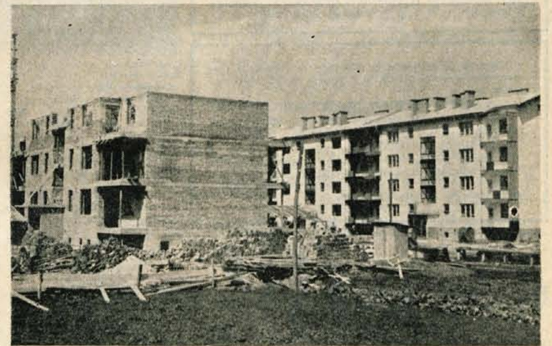
Na Trati končujejo delavci škofjeloškega gradbenega podjetja »Tehnik« lep stanovanjski blok, v katerem bo že to jesen dobilo stanovanje 32 družin. Enaka stanovanjska hiša z 32 stanovanji bo vseljava prihodnje leto. V ta stanovanja se bodo vselile družine delavcev iz »Jelovice« in »Gorenjske predilnice«.
