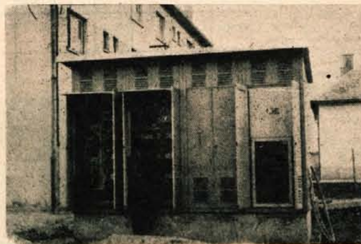
10 kV montažna trafo postaja na Planini
