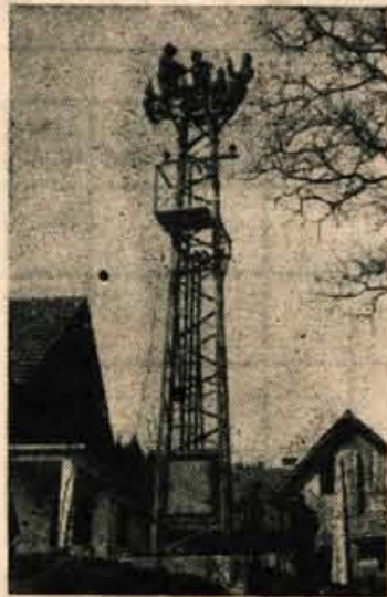
Montaža trafo postaje za novo naselje v Naklem
