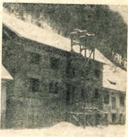
Dvonadstropno poslopje, ki ga gradi KZ Martinj vrh, je že pod streho
