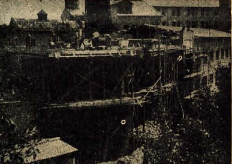
Novi objekt 07 tovarne »Iskra« med gradnjo
