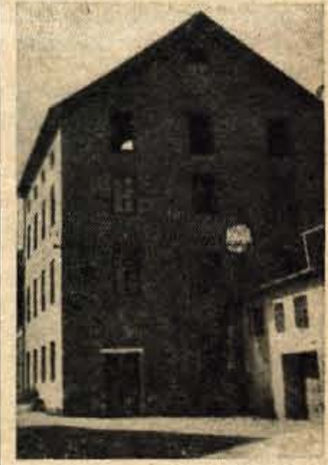
KAMEN spotike Ob Savski cesti nasproti kranjske klavnice stoji že štiri leta velika dvonadstropna stavba skoraj popolnoma prazna. V spodnjih prostorih je imela nekaj časa skladišče tovarne usnja, potem pa je tudi te izpraznila. V »Standardu« smo zvedeli, da je hlaš last splošnega ljudskega premoženja in da je podjetje želelo urediti v njej 6 dvosobnih stanovanj in 4 garsonjere. Niso pa dobili dovoljenja, čemur se delavci spričo velike stanovniške stiske upravičeno čudijo.
