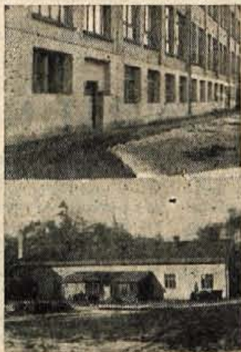
ZGORAJ STAVBA NEKDANJE-GA SAMOSTOJNEGA PODJETJA »PUŠKARNA«, SPODAJ PROSTORI »KOVINARJA«.
