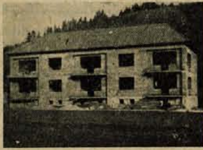
Ta stanovanjski blok v Gorenji vasi bo prihodnje leto sprejel stanovalce
