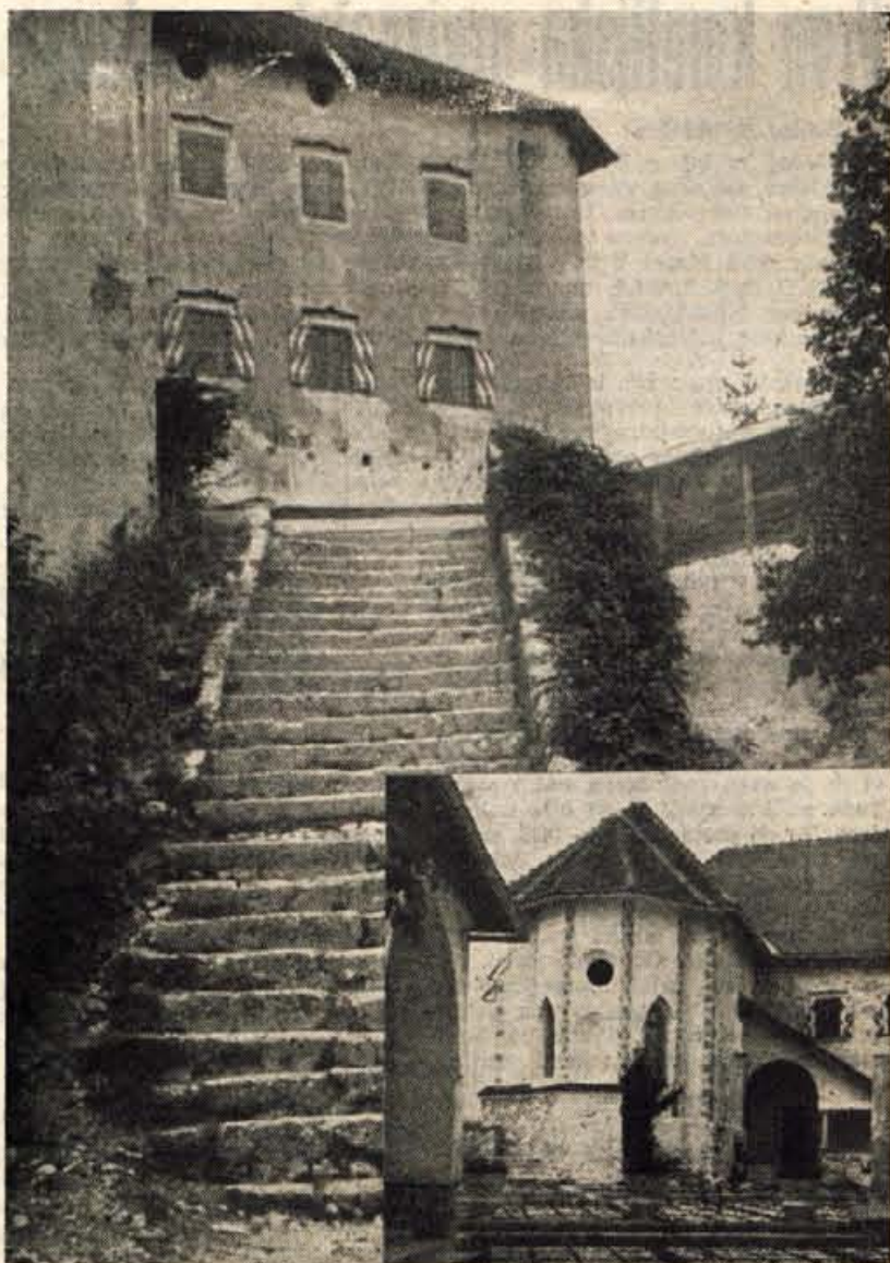
BLEJSKI GRAD OBNAVLJAJO. ZGORAJ VISOKO STOPNIŠČE, SPODAJ OBNOVLJENI DEL GRADU
