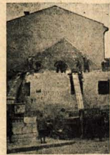
To sredo pa je na gradilišču že zgradilo tako, kot kaže slika. Videti je, da so delavci kljub zimi kar krepko prišli za delo
