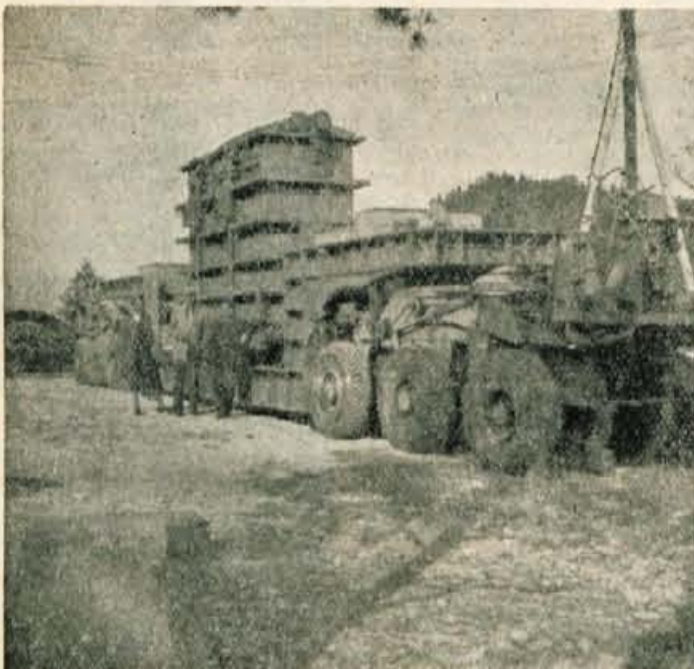
55 tonski transformator so pripeljali s posebno prikolico, ki sama tehta 43 ton in ima nosilnost do 100 ton
