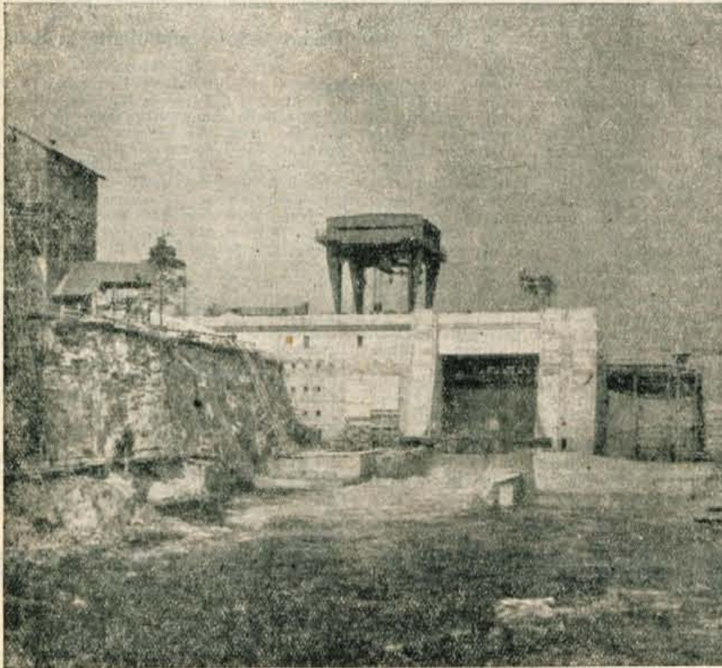
Desna polovica elektrarne je že dograjena. Sedaj se voda pretaka skozi desno pretočno polje, v levem pa že gradijo strojnico
