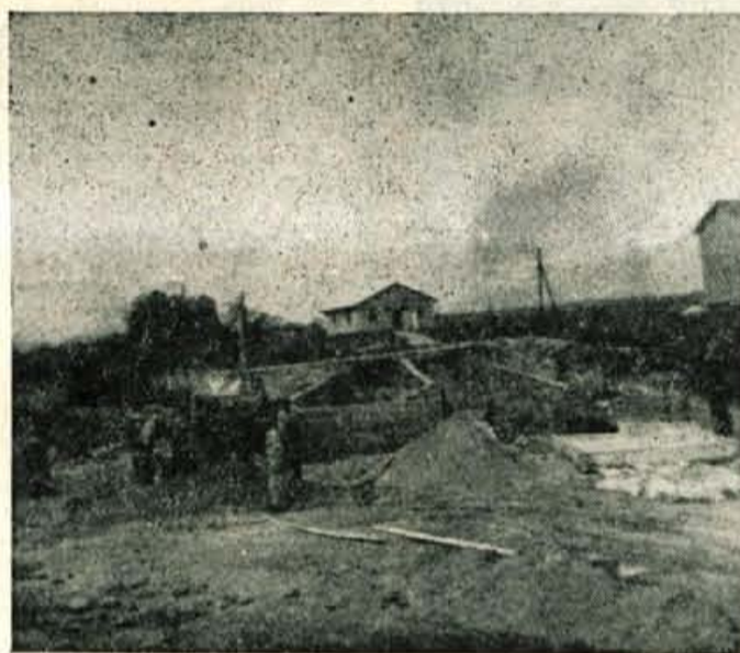
Graditev stanovanjskega bloka na Zlatem polju
