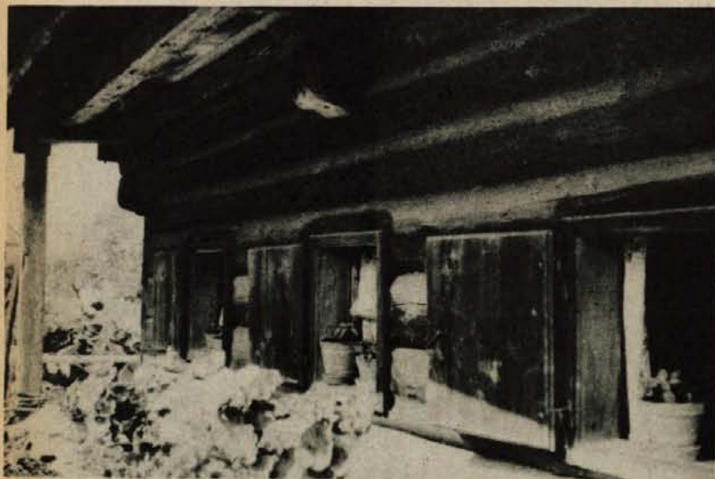
Kranj – Stražišče – Sitarске hiše – detajl fasade
