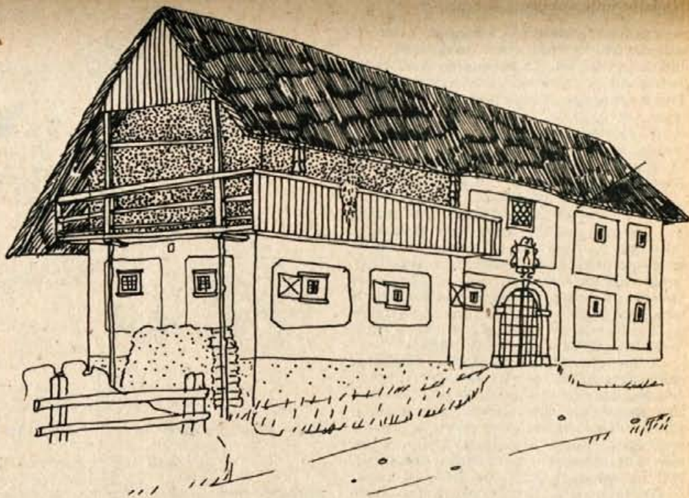
Kmečka zidana stanovanjska hiša, risba po fotografiji, ki je nastala pred letom 1925, ko je bila stavba porušena in na njenem mestu zgrajena meščanska vilah.
