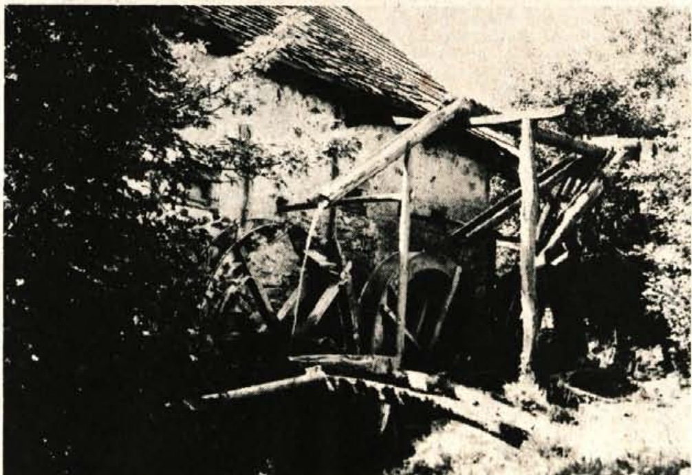
Rokavčev mlin s kolesi na zgornjo vodo v Zlatenku pri Blagovici (foto Drago Holynski)
