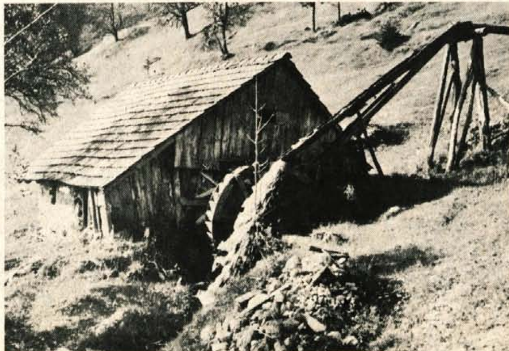
Zarobarjev kmečki mlin pri vasi Suša v Poljanski dolini, kolo na zgornjo vodo (foto Janez Eržen)
