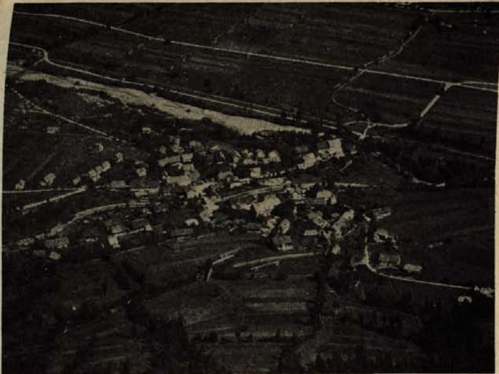
Mojstrana z Grančiša, severno pogled na dovška polja in zahodni del vasi s cerkvijo
