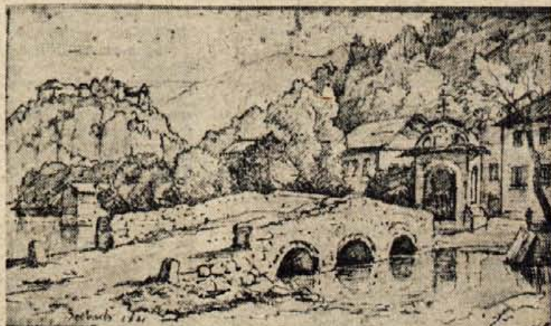
Kamniti most čez Jezernico v Milnem. Most je nadomeščen z betonskim, kapele ni več in tudi hiše so prezidane. V ozadju grad, Karavanke in Straža. V spodnjem levem kotu zapis: Seebach 1831.
