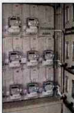
Novi elektronski števec za daljinsko odčitavanje porabe, ki jih je izdelal Iskraemeco.
