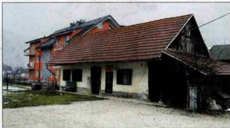
Sporna novogradnja bo nadomestila pritlično hišo ob novem bloku na Mlakarjevi ulici.
