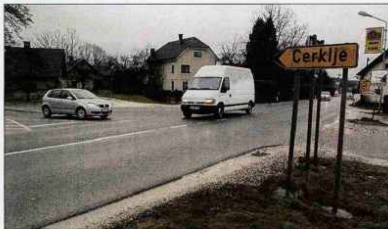
Krožišče na Spodnjem Brniku, na katerega domačini nestrno čakajo že nekaj let, bodo vendarle začeli graditi. Krožišče bo štirikrako, saj bo nanj priključena tudi cesta proti Vodici. / Foto: Gorazd Kavčič
