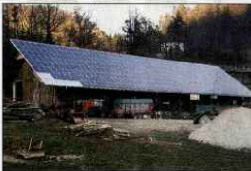
Sončna elektrarna na strehi Mulejevega hleva
