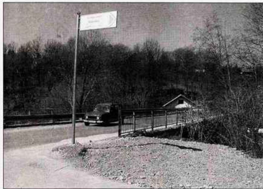
Bunker pred mostom so odstranili, da bi razširili pločnik s kolesarsko stezo.
