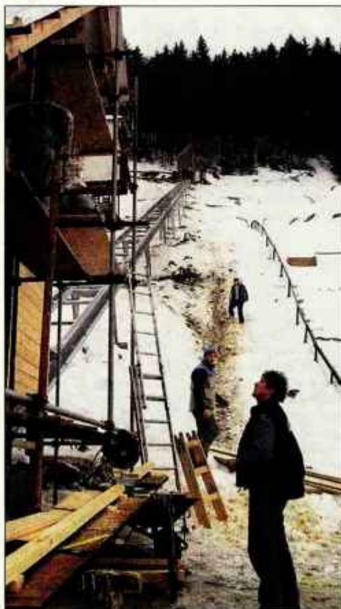
Te dni so ob skakalnicah v Žireh opravili še zadnja dela za zagon vzpenjače.
