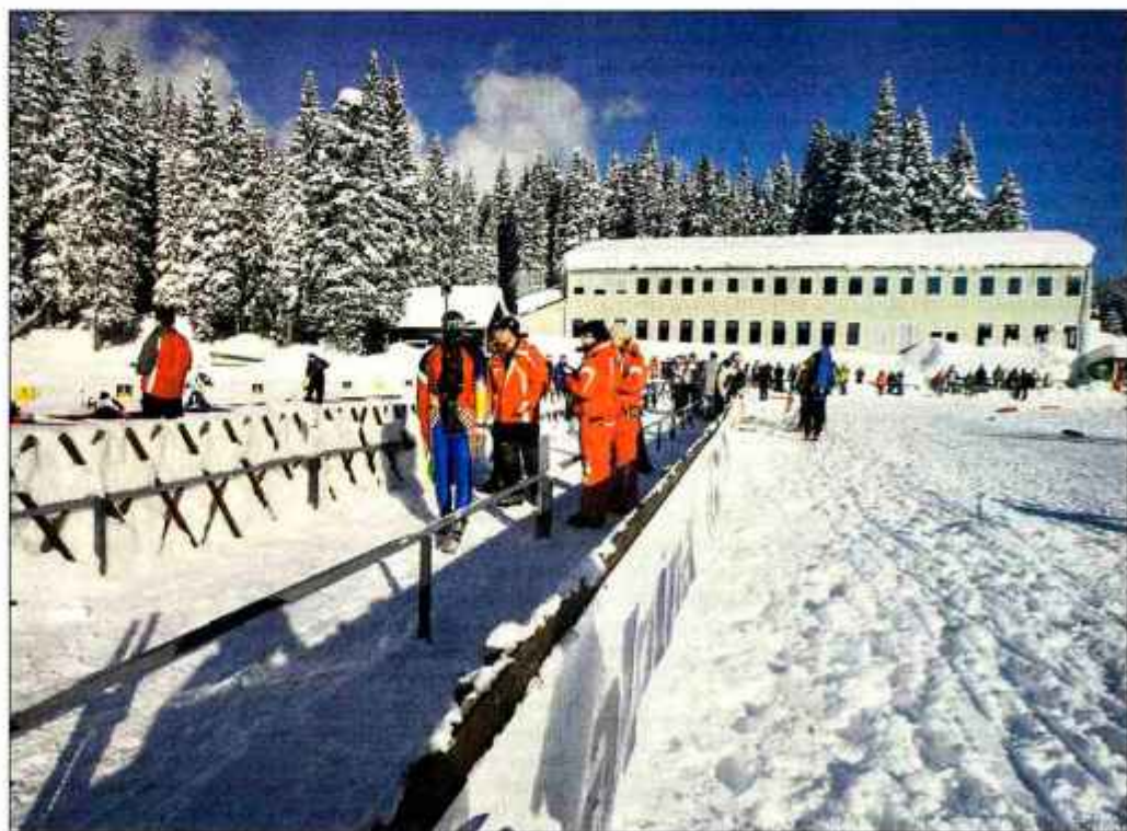
Montažni objekt ob strelišču je "siva" gradnja in ga bodo najverjetneje podri spomladi. Namesto njega želijo postaviti novega, ob njem pa še mini kamp. /Foto: Tina Doki
