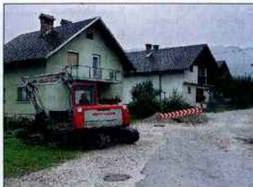
V Ribnem bodo zgradili še 400 metrov kanalizacijskega omrežja.
