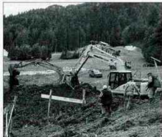
Izkop za temelje sedmega stebra na trasi štirisedežnice.
