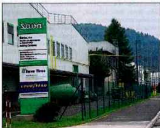
Na dvorišču Save so v gradnji nove proizvodne stavbe in poslovni prostori programa za zaščito okolja Eko družbe Savatech, ki bodo dokončani do konca letošnjega leta.
