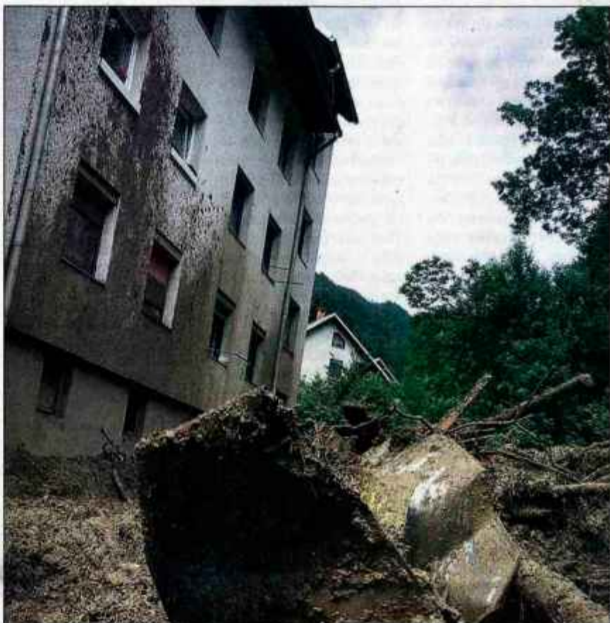
Sledovi zemeljskega plazsu segajo do drugega nadstropja stanovanjskega bloka Ravne 23, 24.
