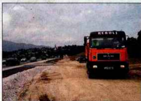
Na kratkem, a zahtevnem odseku (s tremi viadukti in predorom) so že začeli s pripravljalnimi deli. / Foto: Gorazd Kavčič
