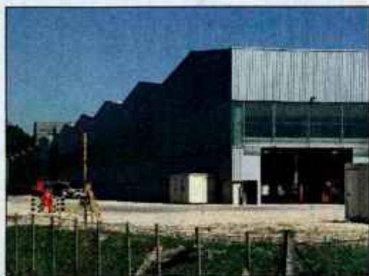
Z dogradnjo skladišč so povečali skladiščne površine za metalurške izdelke za več kot dvakrat.
