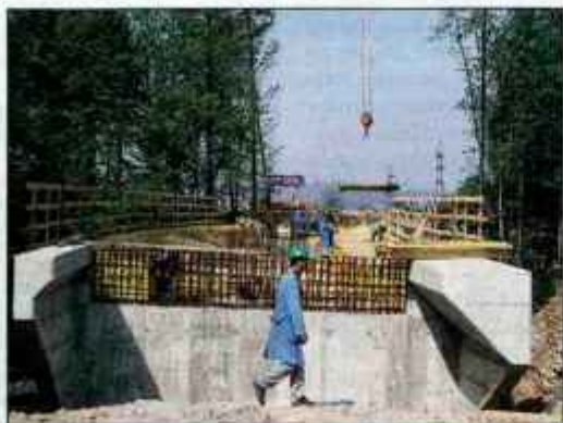
Največji objekt na novi cesti v poslovno cono je most v kanjonu Temnik.
