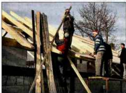
Na letnem kopališču gradijo nove garderobe in sanitarije.
