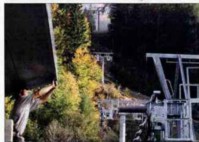
Dvanajst jeklenih stebrov so postavili s pomočjo helikopterja.
