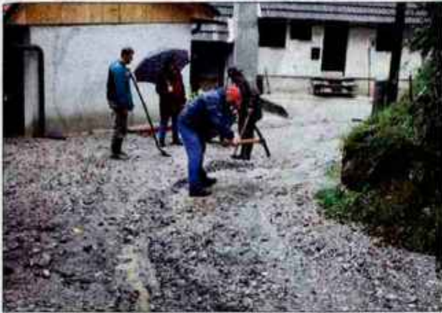
Deroča voda je uničila cesto na Taboru.
