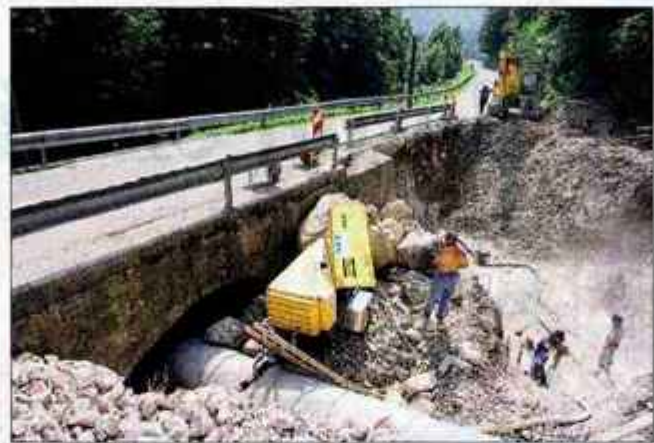
Veliko gradbišče na začetku doline Kokre na mostu pod Čemšenikom.
