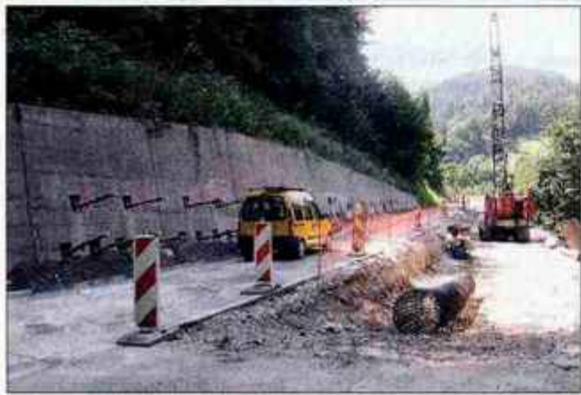
Sidranje zgornje stene je zaključeno, sedaj je potrebno utrditi še podporni zid.
