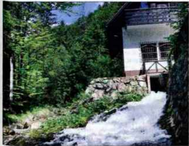
Mala vodna elektrarna Žingarica v zgornjem predelu Završnice.
