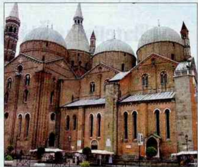
Mogočna bazilika Antona Padovanskega v Padovi v Italiji. Dolga je 120 in široka 60 metrov. Ima 8 kupol, 2 zvonika in 2 stolpca.
