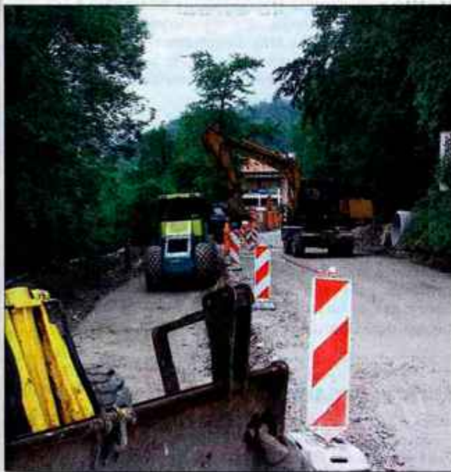
Dela na odseku od kamnitega mostu v Stranjah do križišča za Kamniško Bistrico so ovrednotena na 350 milijonov tolarjev.
