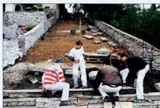
Južno stopnišče mora biti končano do 18. junija, zato bodo delavci delali v treh izmenah.
