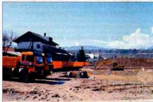
Na severozahodnem delu Nakla gradijo zdravstveni dom.
