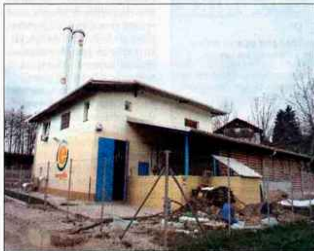
Kotlovnica daljinskega sistema na biomaso zaradi bližine razburja sosedov, občina podpira zahteve po njeni prestavitvi, vendar je trenutno zaradi svoje finančne nezmožnosti lahko le solidarna s stanovalci.
