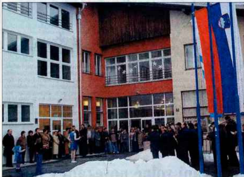
Z gradnjo prizidka so začeli lani poleti.
