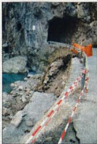
Tudi pred cestnim predorom v Dovžanovi soteski popravljajo podporni zid.
