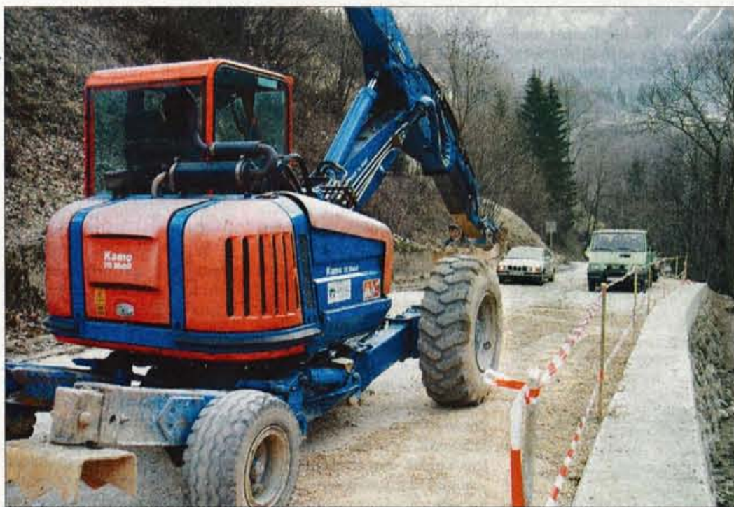
Pri vasi Čadovlje je že zgrajen nov oporni zid, ob njem pa so te dni nasipali in utrjevali makadamsko cestišče.
