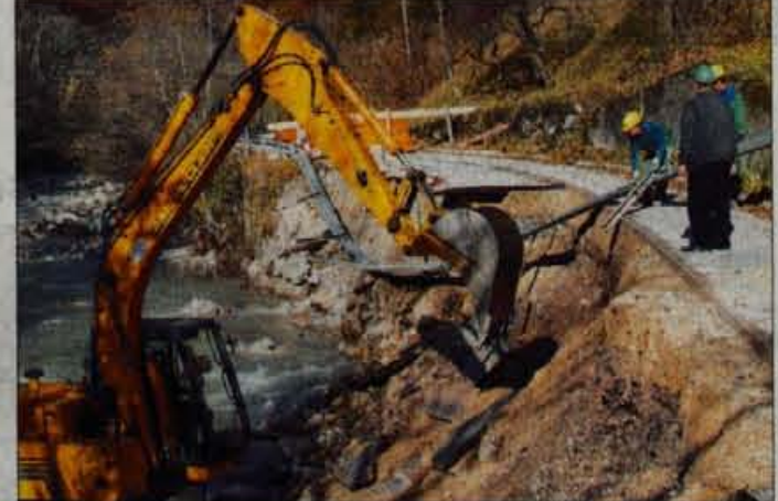
V torek so stekla dela za popravilo poškodovane ceste Trzič - Dolina.
