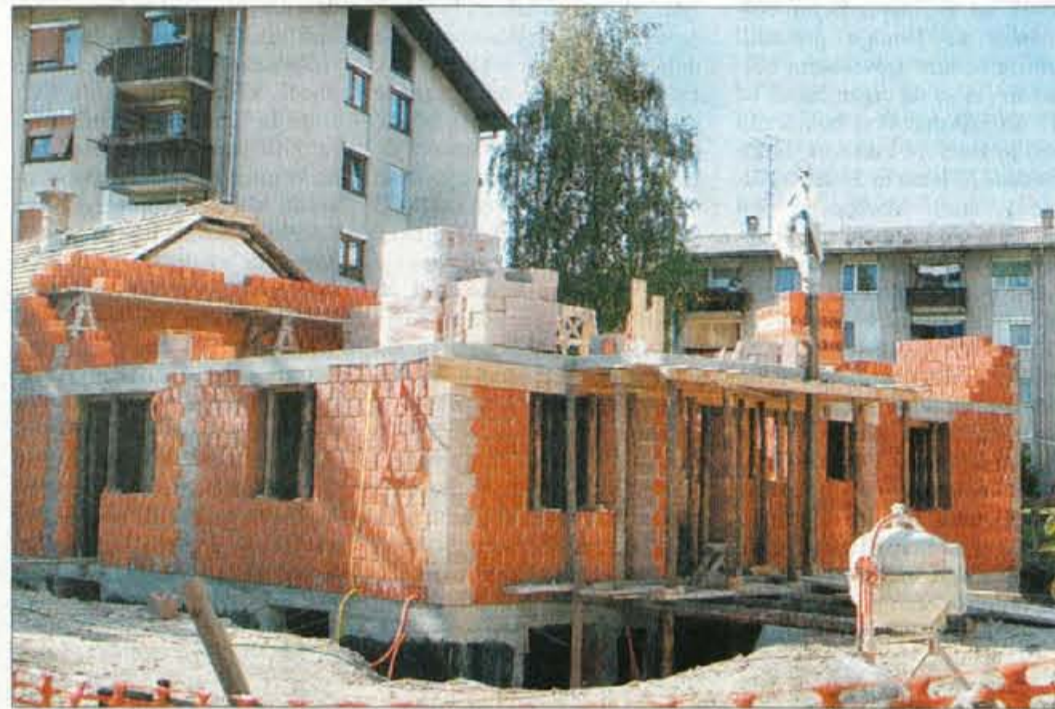
Nadomestna gradnja na Partizanski 29 a je začasno ustavljena. - Foto: Tina Dokl
