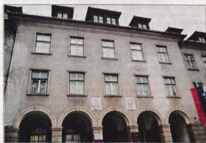
S sanacijo ogrevalnega sistema v kranjski občinski stavbi bodo letno privarčevali 3,5 milijona tolarjev.
