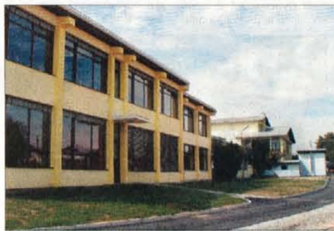
Včeraj pozno popoldne so slovesno odprli prizidek k šoli in ulico ob šoli z novo prometno ureditvijo.
