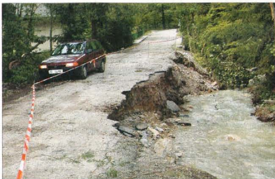
Del ceste v Srednji vrh je kar odneslo - sanacijo bo opravil SCT v mesecu dni.
