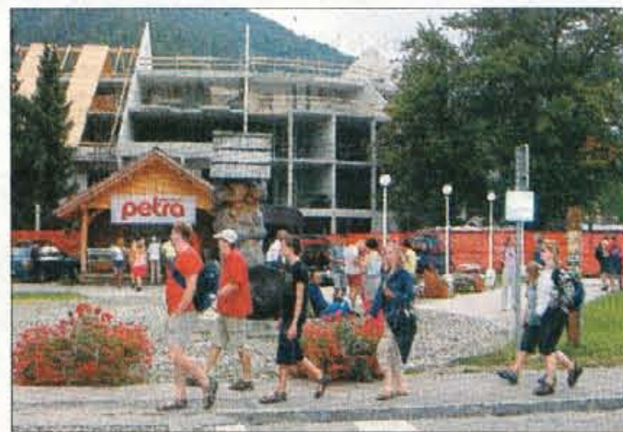
Letos središče Kranjske Gore ni tako lepo kot ponavadi, saj se gradi hotel Prisank.
